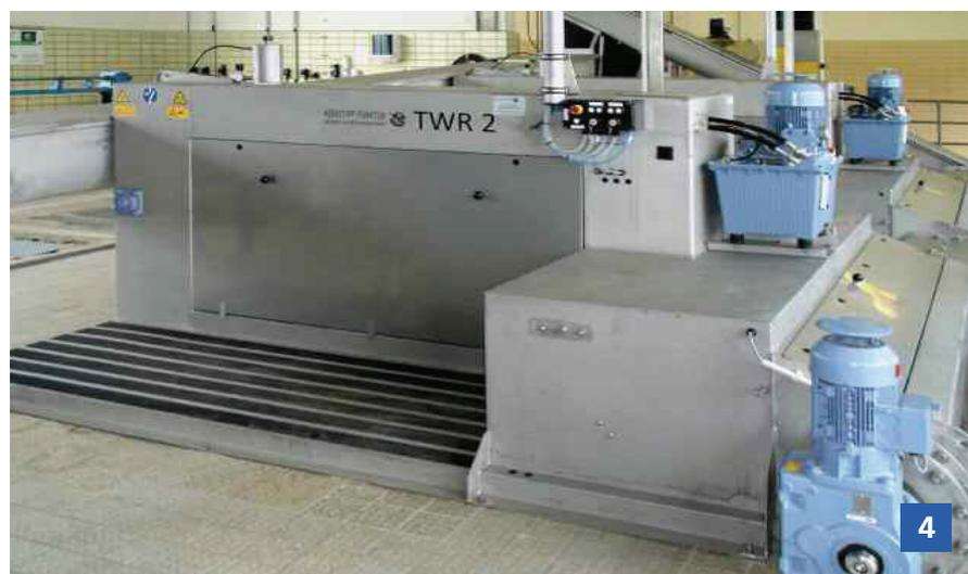
compacteur-laveur des déchets intégré. Les déchets remontés par le bras racleur sont évacués sans action mécanique par-dessus la lame supérieure de la grille, vers le compacteur-laveur. Dans celui-ci, toutes les matières fécales sont séparées des déchets par un lavage vigoureux dans l'auge de la vis, ces eaux de lavage chargées retournent dans les eaux usées.
