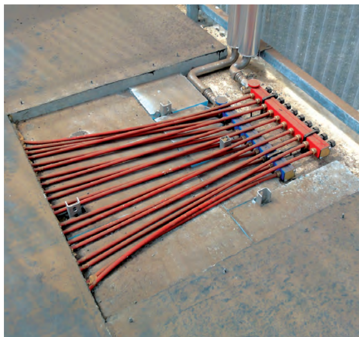
▲ Mise en température par un plancher chauffant pour assurer le séchage pendant les périodes froides. La pompe à chaleur est alimentée par l'eau traitée en sortie de clarificateur.
